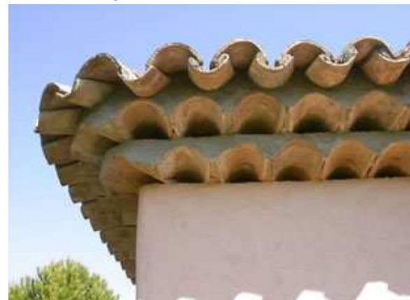
Génoise et tuiles canal
