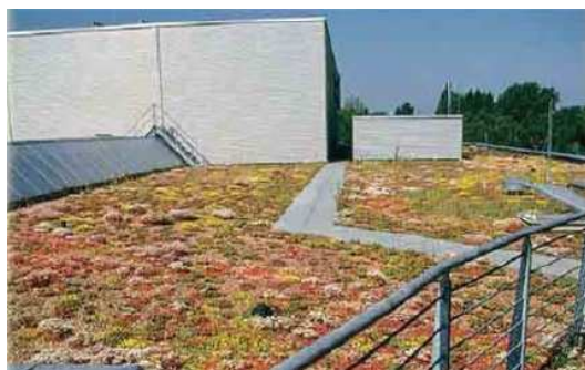
Toiture végétalisée extensive
