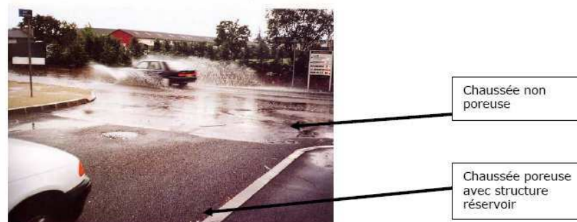
Chaussée à structure réservoir, Craponne (CERTU - 1994)
